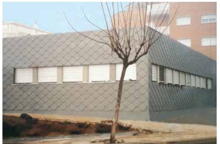
Centro de atención primaria, Caldes de Montbui
