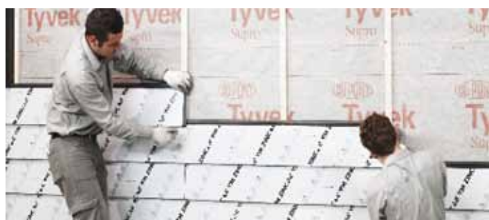
4 Luego, instalar los perfiles como esta descrito "Instalación en 7 pasos"
